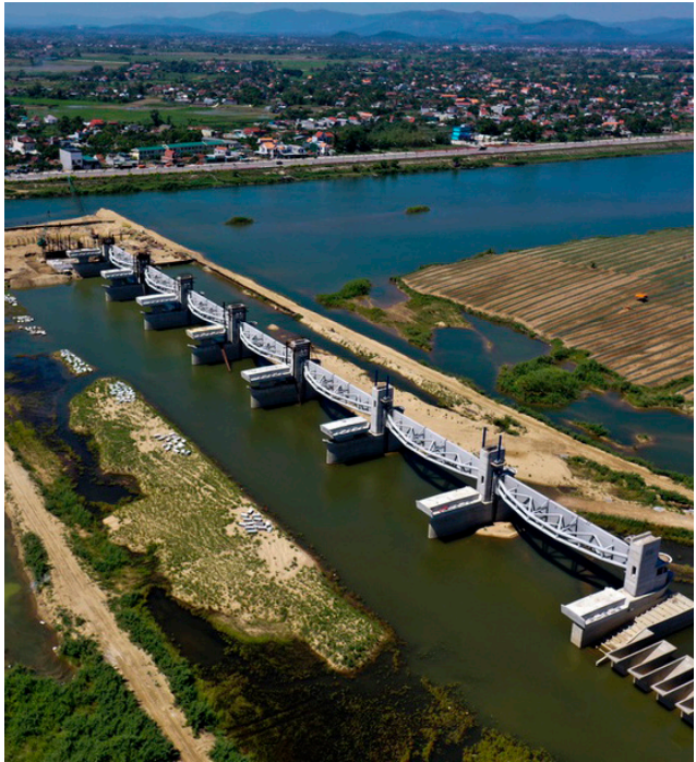
ĐẬP DÂNG HẠ LƯU SÔNG TRÀ KHÚC DAM DOWNSTREAM OF TRA KHUC RIVER
